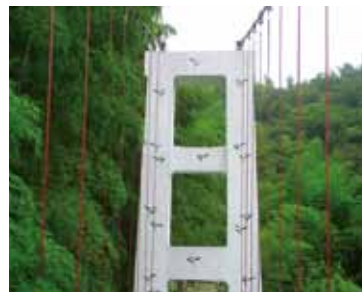
鋼筋混凝土橋塔
